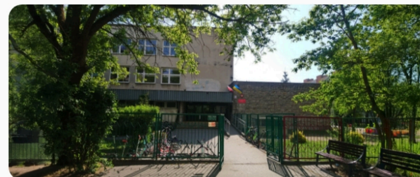
Wejście główne do Szkoły Podstawowej nr 401 w Warszawie.
